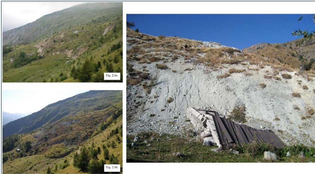
Abb. 19: Fuß der Rutschung von Sampeyre. Die Bilder links (Arpa Piemonte, 2009) zeigen das Vorrücken der Rutschungsstirn im November 2009 im Abstand von 10 Tagen; die Rutschung erreichte damals eine Häusergruppe, das Foto rechts zeigt einen durch die Rutschung zerstörten Schuppen.
