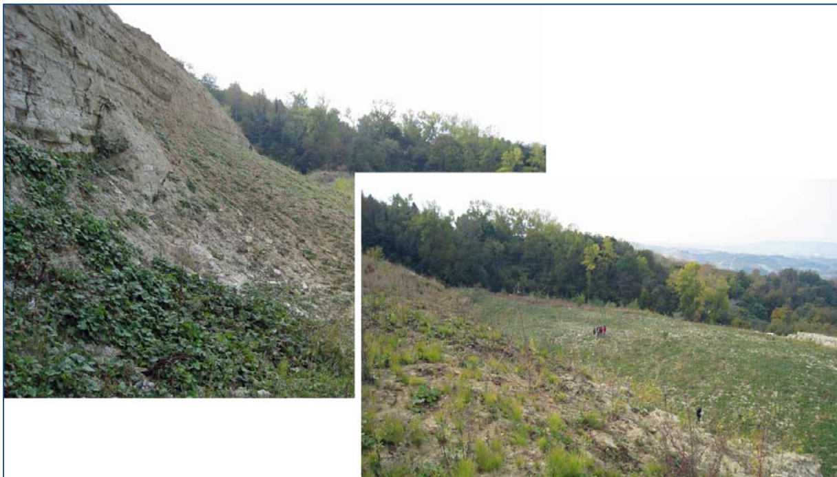
Abb. 31: Rutschung von Barili: Situation, wie sich die Rutschung heute präsentiert. Das Bild links zeigt die Abrisskante, die sich 2010 gebildet hatte (siehe auch Abb. 30).
