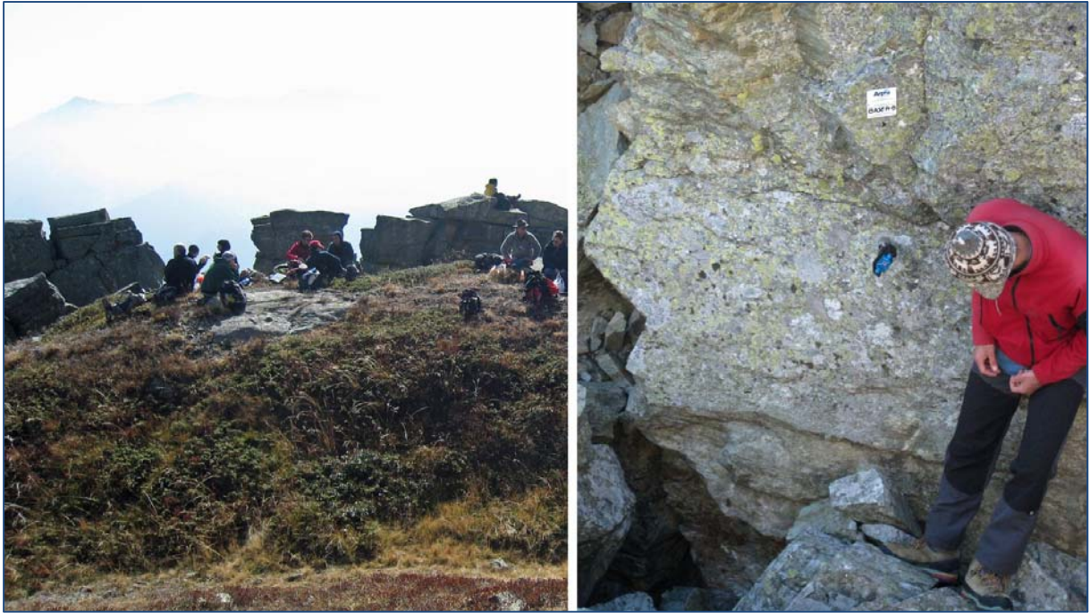
Abb. 17: Hangparallel kippende Felsrippe (links) mit Vermessungspunkt für ein elektronisches Extensometer (rechts).
